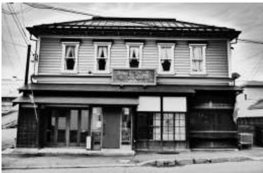
函館 上下和洋折衷建築
